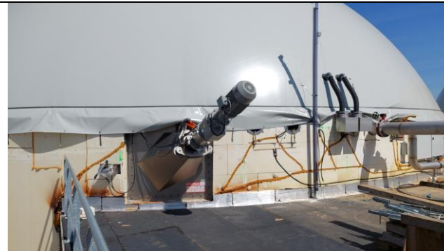
Dalle haute digesteurs, équipements
