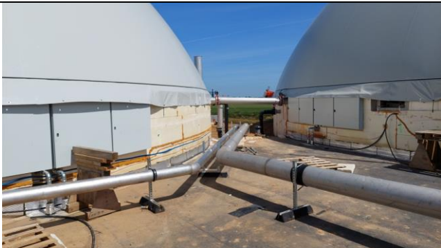
Dalle haute digesteurs, équipements
