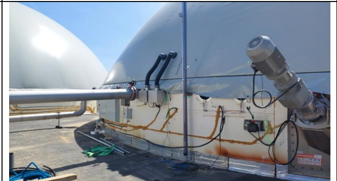
Dalle haute digesteurs, équipements
